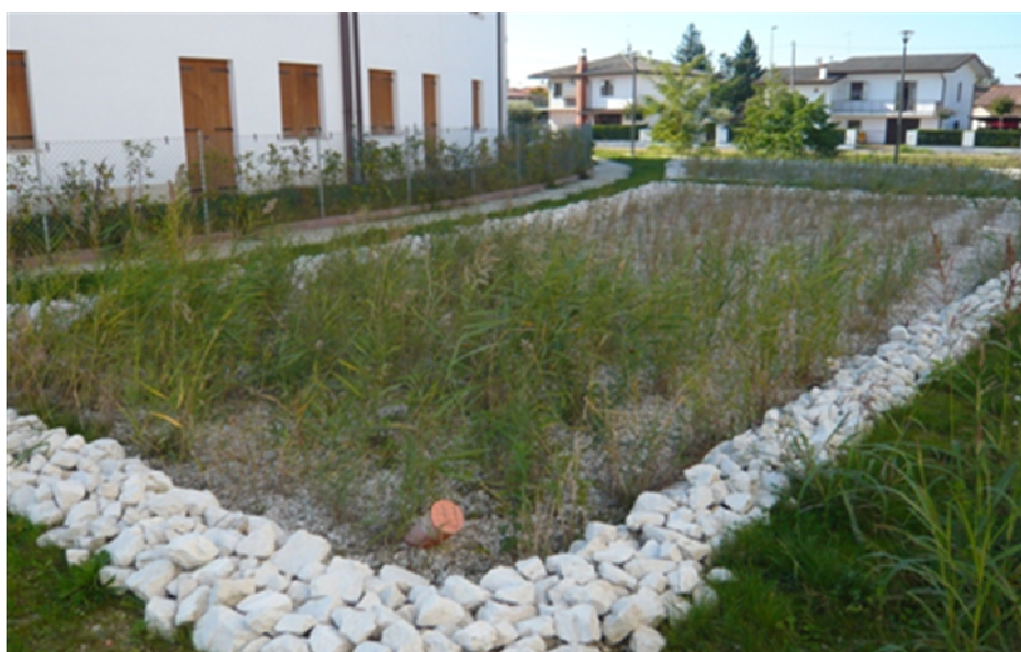
Sistema a flusso orizzontale per il riuso di acque grigie a Preganziol (TV) per 240 a.e
