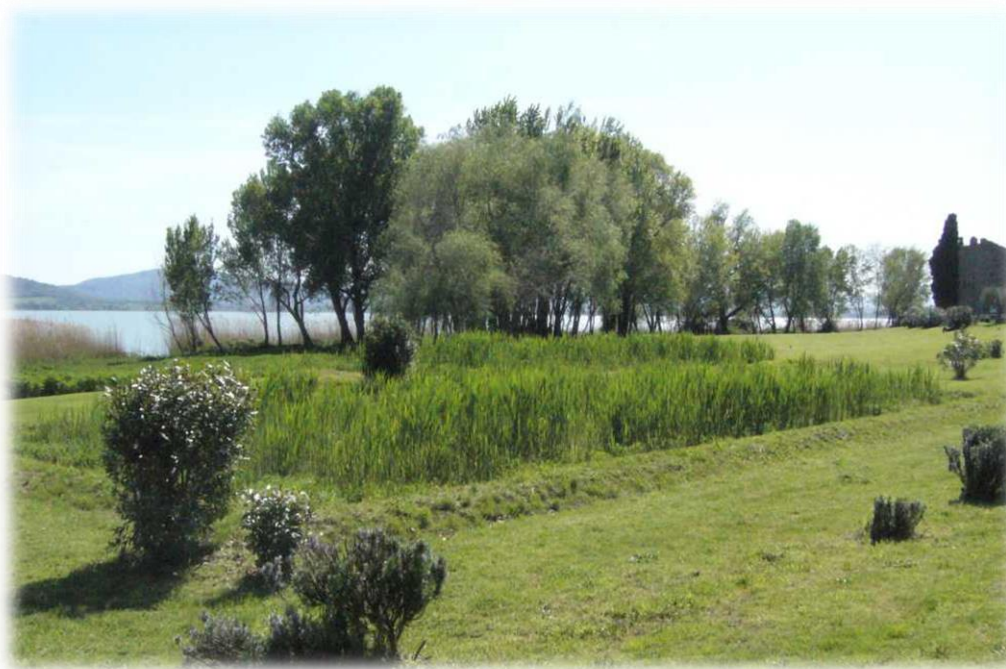
Fitodepurazione HF da 100 a.e. Isola di Polvese (L. Trasimeno, PG)
